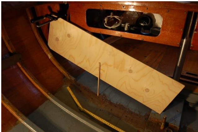
Här mallas spantkurvan av. Sedan skall den översättas till den riktiga formen där det nya spantet skall byggas
